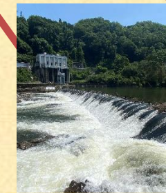
相楽発電所取水堰
