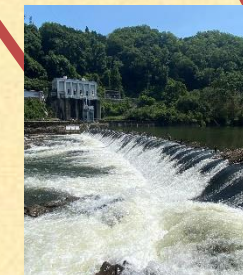
相楽発電所取水堰
